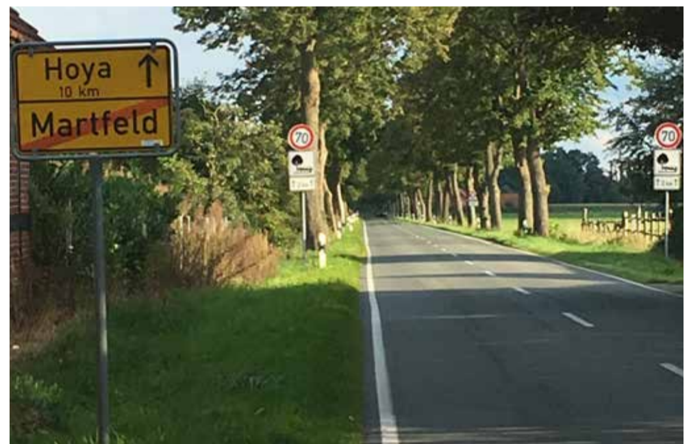
An der Hoyaer Straße in Martfeld soll der neue Radweg nach Loge gebaut werden. Der Grund ist die lange gerade Straße, auf der sehr schnell gefahren wird. Für die Pedalritter bedeutet der Radweg mehr Sicherheit. Foto: R. Peper
